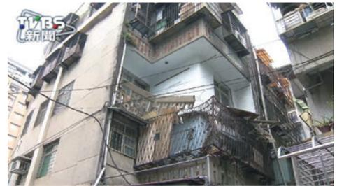
新北市某公寓因屋況老舊 鋼筋鏽蝕導致後陽台崩塌 摘自 TVBS 新聞畫面
